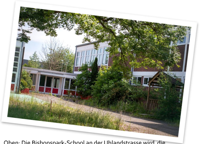
Oben: Die Bishopspark-School an der Uhlandstrasse wird die Ausweichschule während der Sanierung sein.
